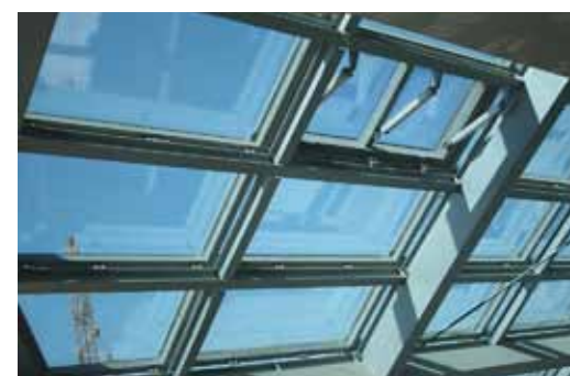
Рис. 4.6.2.5. Удаление продуктов сгорания через светопрозрачные конструкции, оборудованные системами дымоудаления. Экстренная эвакуация из здания. Открывающиеся фрамуги в светопрозрачной кровле с автоматически управляемыми электроприводами
