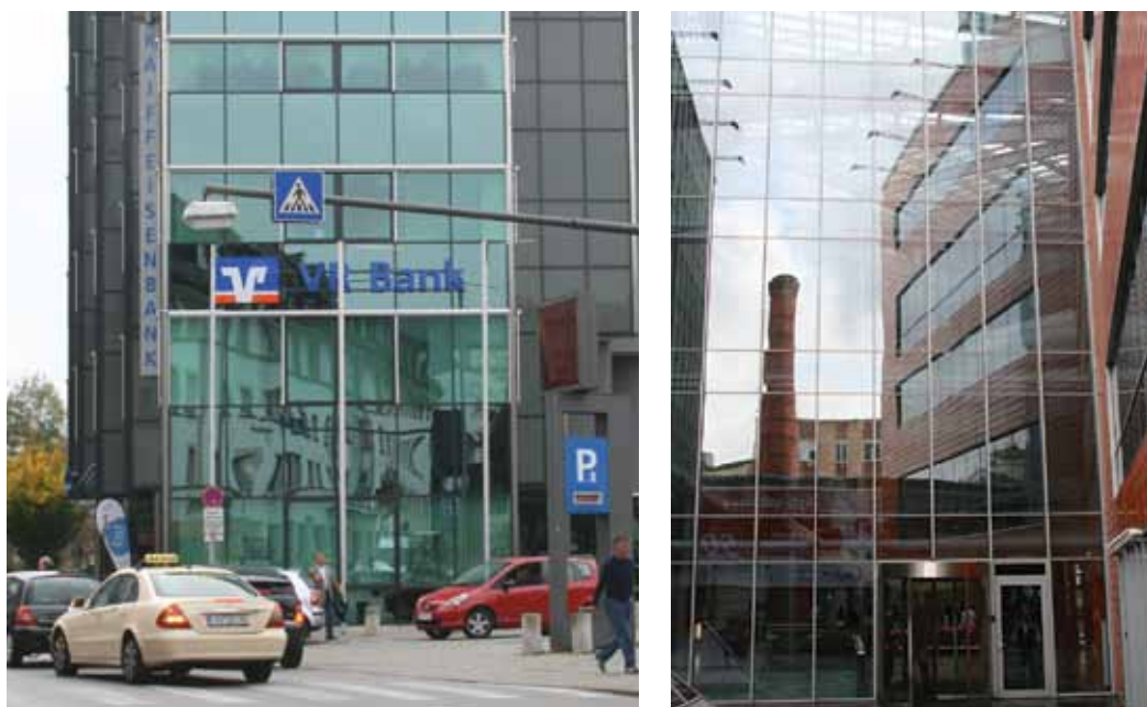
Рис. 4.3.1. Зрительные искажения фасадной плоскости зданий с герметичными стеклопакетами.
