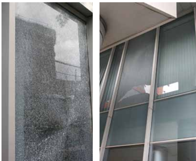
Рис. 4.7.9. Разрушение закалённых стёкол в стеклопакетах офисного комплекса Серебряный город, г. Москва
