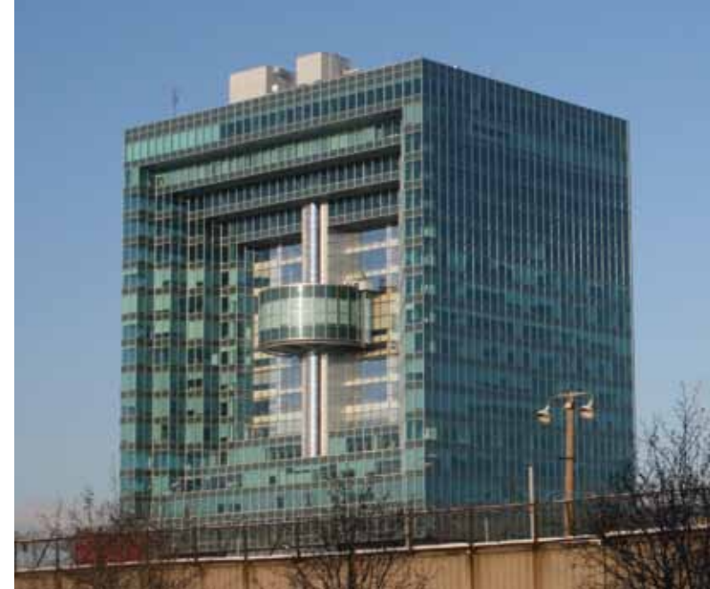
Рис. 3.3.1. Общий вид административно-офисного здания с полностью остеклёнными фасадами и внутренней солнцезащитой, г. Москва
