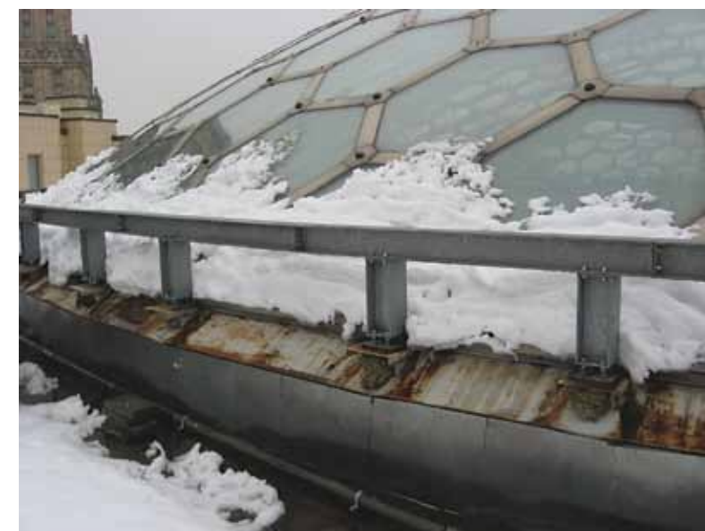
Рис.4.7.14. Распределение снеговой нагрузки и локальное льдообразование на куполе служебного здания МИД РФ.
