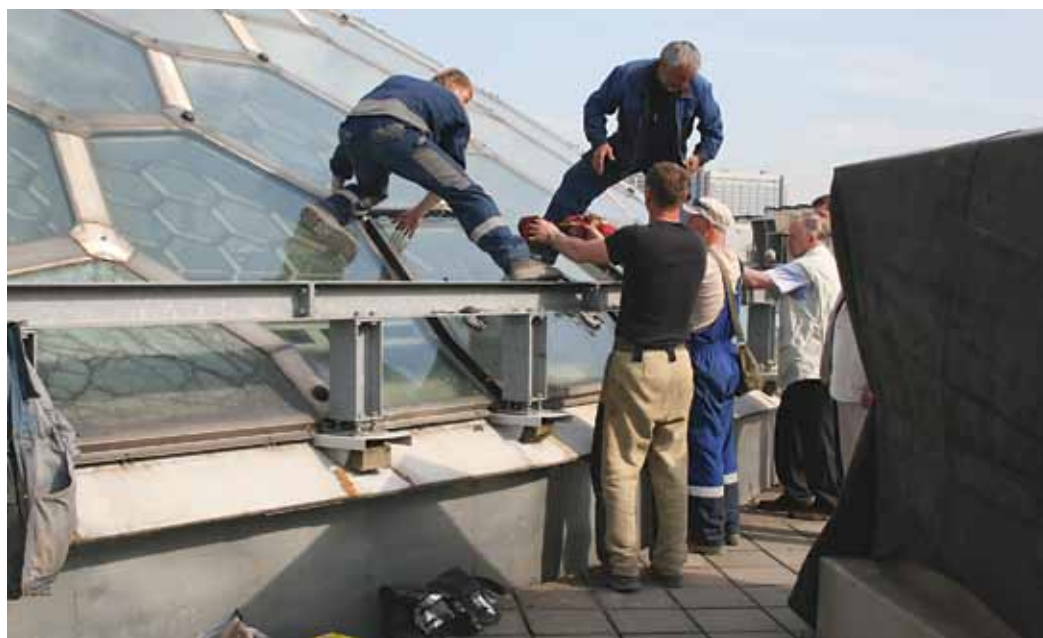
Рис. 4.7.13. Обследование стеклопакетов светопрозрачного купола служебного здания МИД РФ. а) Разрушение верхнего закалённого стекла в трёх стеклопакетах нижнего контура; б) Вскрытие конструктивной ячейки купола – демонтаж стеклопакета.
