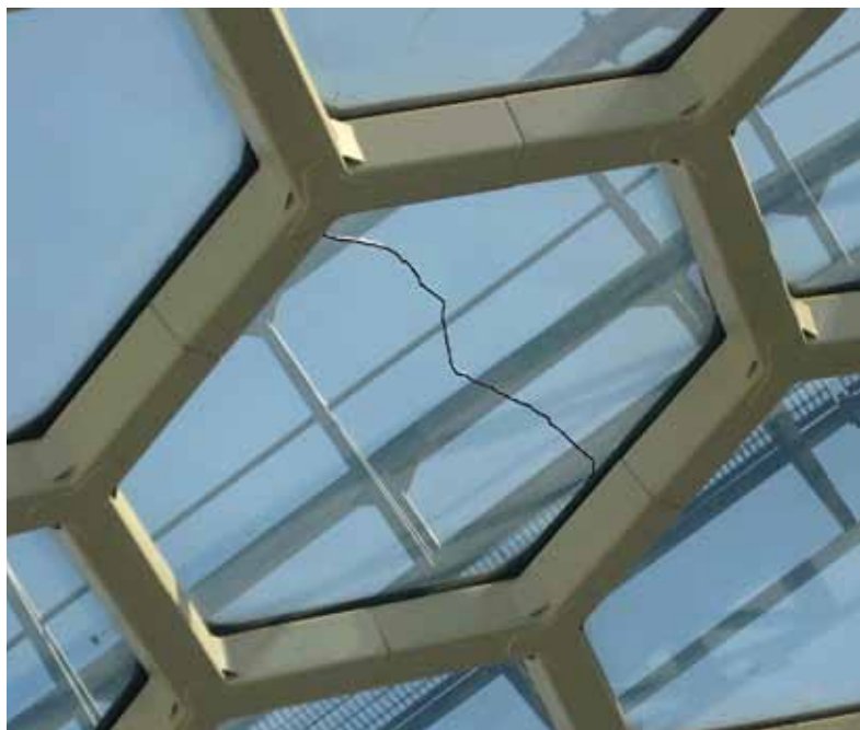
Рис.4.7.15. Трещина в стеклопакете сложной формы, вызванная неравномерным опиранием на несущие конструкции кровли
