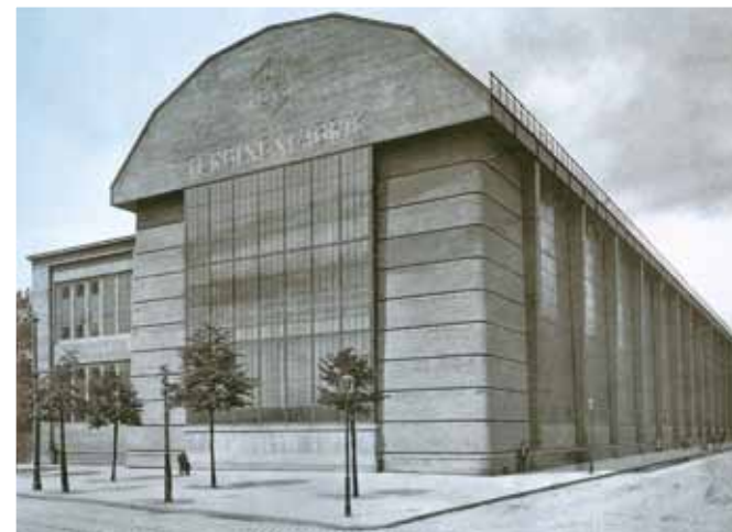
а) Турбинный завод АЕГ, Берлин, Арх. П. Беренс. 1908–1909 г.
