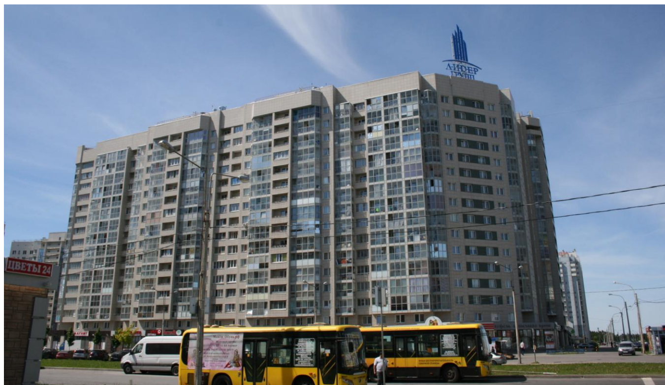
Рис.96. Внешний вид многоэтажного жилого дома с полностью остекленными балконами после нескольких лет эксплуатации.
