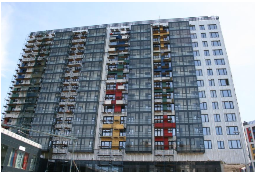
Рис.8. Панорамное балконное остекление с применением закаленного окрашенного стекла в нижнем экране
